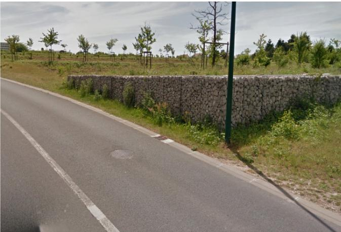
Traitement d'un mur de soutènement de la zone d'activités à Vineuil (41) : réalisation d'un gabion en calcaire permettant une bonne intégration de la paroi dans le paysage.
