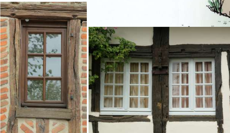
1 2 Fenêtre avec cadre. La distance entre les pans de bois détermine les dimensions de la fenêtre
