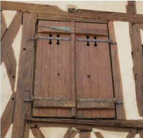
5 Les volets sont majoritairement situés à l'intérieur. Ils peuvent parfois être à l'extérieur notamment au rez-de-chaussée
