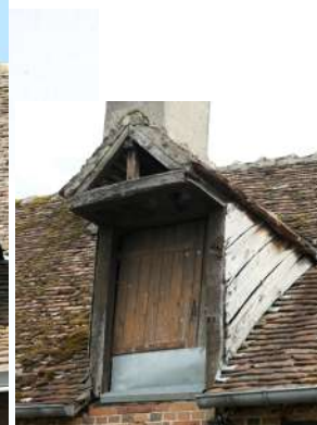
8 9 Lucarne à croupe (photo de gauche), lucarne pignon (photo de droite). Les deux lucarnes sont débordantes pour accueillir une poulie
