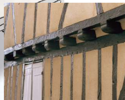
Encorbellement : peu courant en milieu rural, s'il existe, il est plutôt sobre avec un débordement réduit
