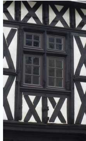
3 4 Fenêtres à meneau et traverses
