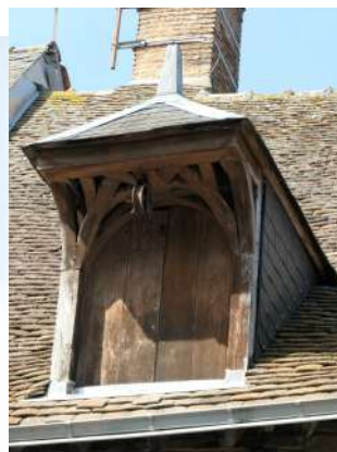
8 9 Lucarne à croupe (photo de gauche), lucarne pignon (photo de droite). Les deux lucarnes sont débordantes pour accueillir une poulie
