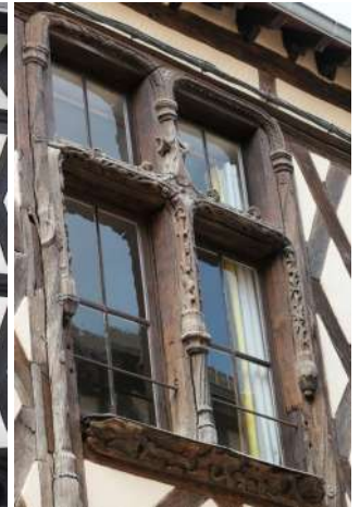
3 4 Fenêtres à meneau et traverses
