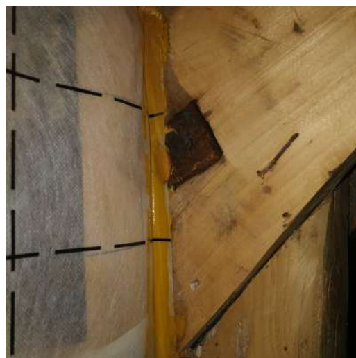
Jointoiment de la membrane hygro-variable avec les éléments d'une charpente
