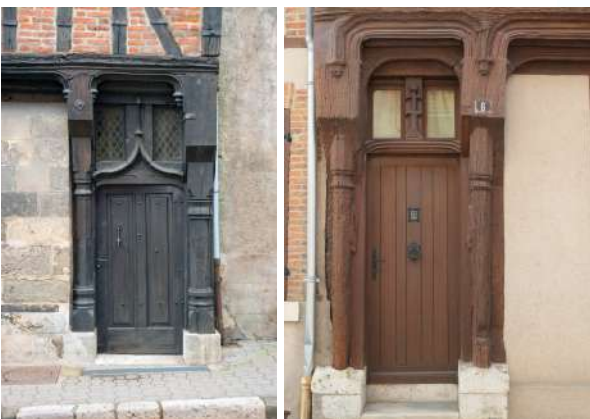
6 Les portes sont surmontées d'une imposte vitrée. Les encadrements sont souvent sculptés
