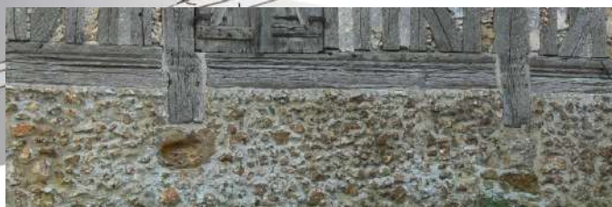
9 Soubassement qui peut être maçonné avec divers matériaux (briques, pierres, moellons, silex)
