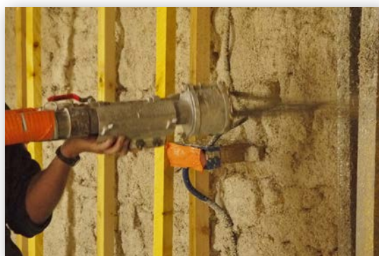
Projection d'un enduit isolant (béton chaux-chanvre).
