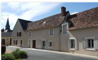
Immeuble Petit-Jean Rivarenes (2013-2015)
