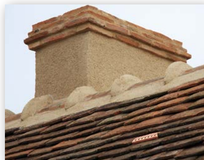
Chatière en cuivre. Le cuivre en s'oxydant prend la couleur des tuiles.
