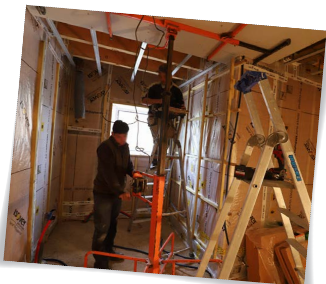
Projet de rénovation d'une longère - Lurais (36)
