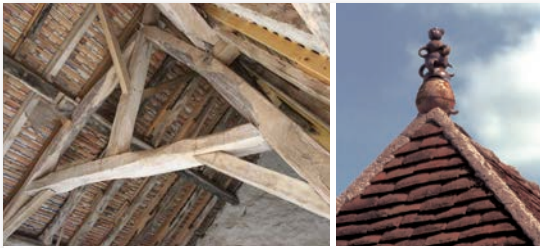
4 Charpente en bois, de chêne, de peuplier et plus rarement d'orme, souvent à entrain retroussé. Tuiles plates en terre cuite plus ou moins galbées avec ergot (ou nez).
