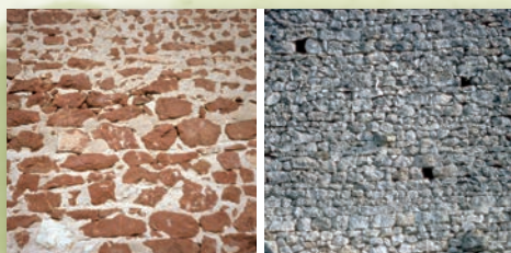
2 En grès rouge, ocre ou noir, ou en calcaire, les murs sont maçonnés à la terre et enduits à la chaux naturelle.
