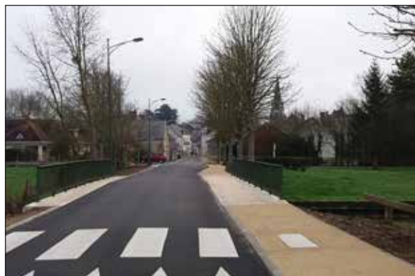
D'importants travaux ont déjà été réalisés à l'entrée du village.
