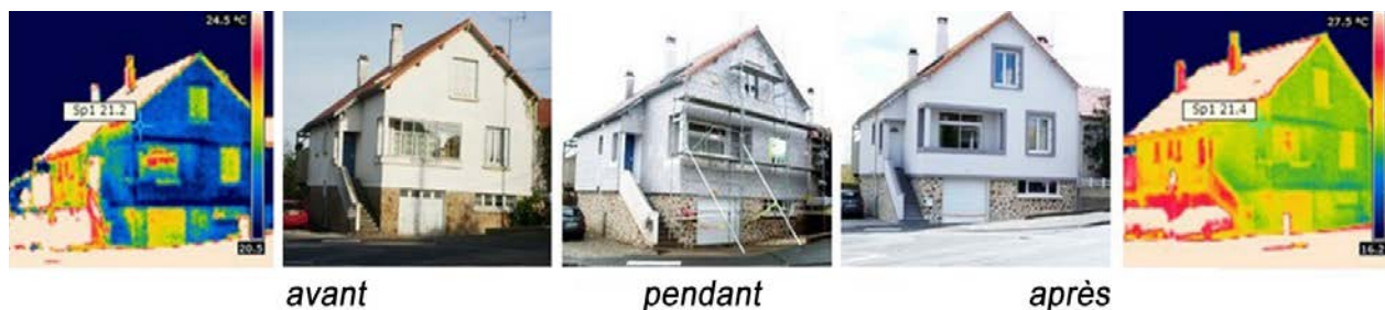
Exemple de transformation d'une maison individuelle dans le cadre d'une rénovation thermique performante
