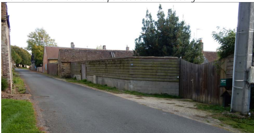
Mur-bahut surmonté d'une palissade dans le bourg
