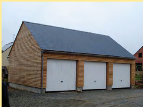
Garages regroupés, construction bois
