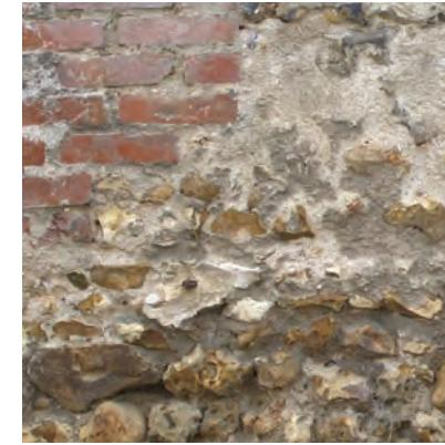
Enduit dégradé laissant apparaître les moellons
