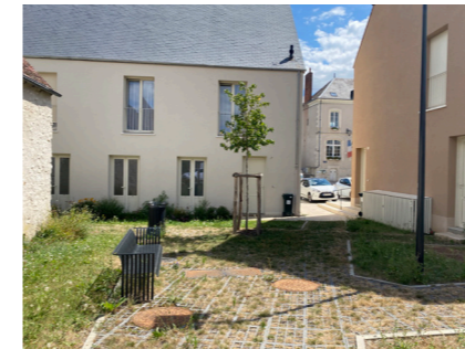
Revêtement alvéolaire - Chouzy-sur-Cisse
