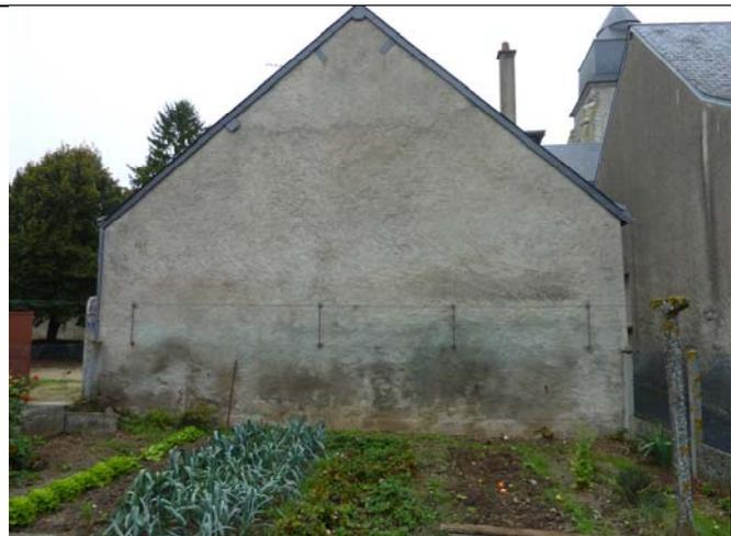
Sur ce pignon il n'existe en revanche aucun débord existant : la réfection complète de l'isolation en rampant supposerait ici une dépose de la toiture existante, un sur chevronnage qui permettrait de créer des débords et recouvrir le pignon
