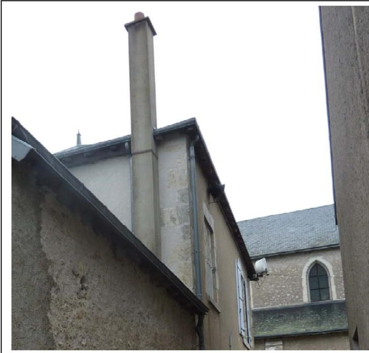
La cheminée existante donnant sur l'extérieur, elle doit être démolie et refaite dans la logique ou on isole par l'extérieur
