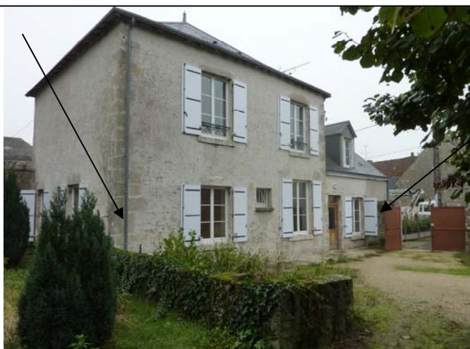
Sur cette facade, le chaînage n'est pas « droit », ce qui apporte une contrainte si le choix se porte sur des panneaux isolants ou une structure préfabriquée rapportée
