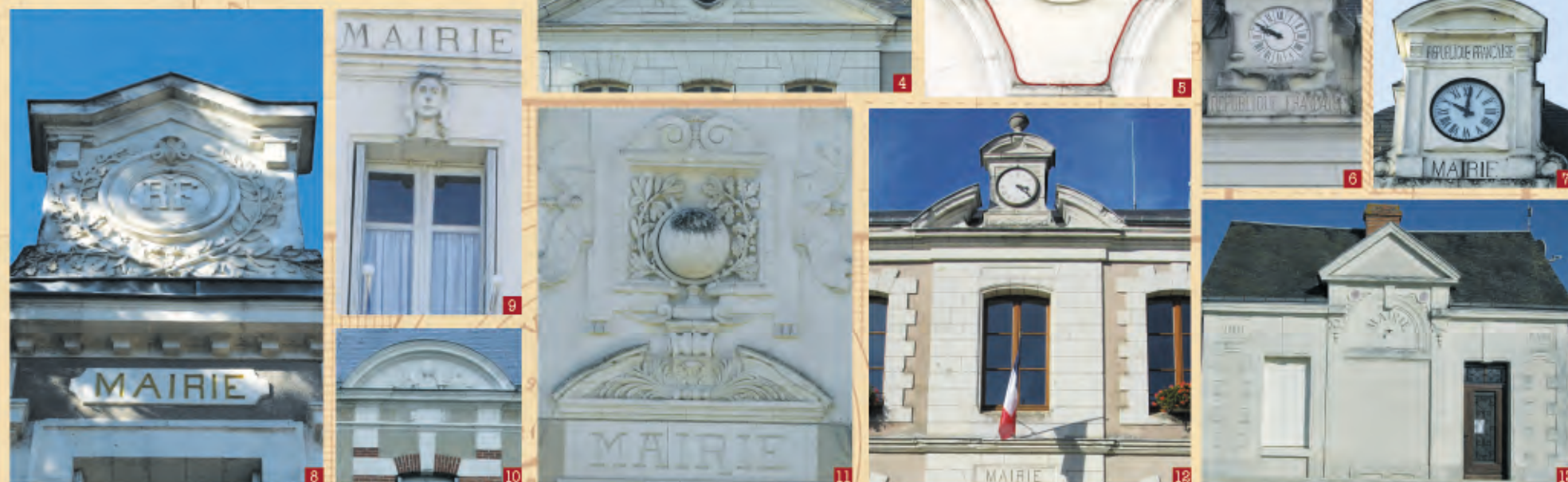
1. Groupe scolaire de Chissay-en-Touraine - 2. Mairie de Mazangé - 3. Mairie de Meusnes - 4. Mairie de La Colombe - 5. Mairie de Huisseau-sur-Cosson - 6. Mairie de Villebarou - 7. Mairie de Saint-Sulpice - 8. Mairie de Mazangé - 9. Mairie-école de Châtres-sur-Cher - 10. Ancienne école de garçons de Saint-Denis-sur-Loire - 11. Mairie de Mareuil-sur-Cher - 12. Mairie de Monteaux - 13. Mairie de Périgny
